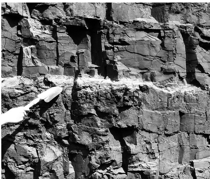
Ryc. 1.6. Spękania w pokładzie węgla brunatnego w odkrywcę Józwin IIB
